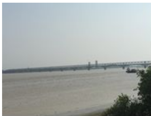
ミャンマーにある Yangon-Thanlyin Bridge 2017年3月筆者撮影
