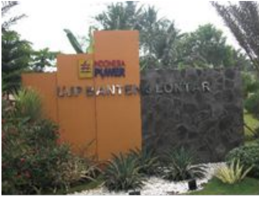
西ジャワ島にある蒸気発電所 2017年7月筆者撮影
